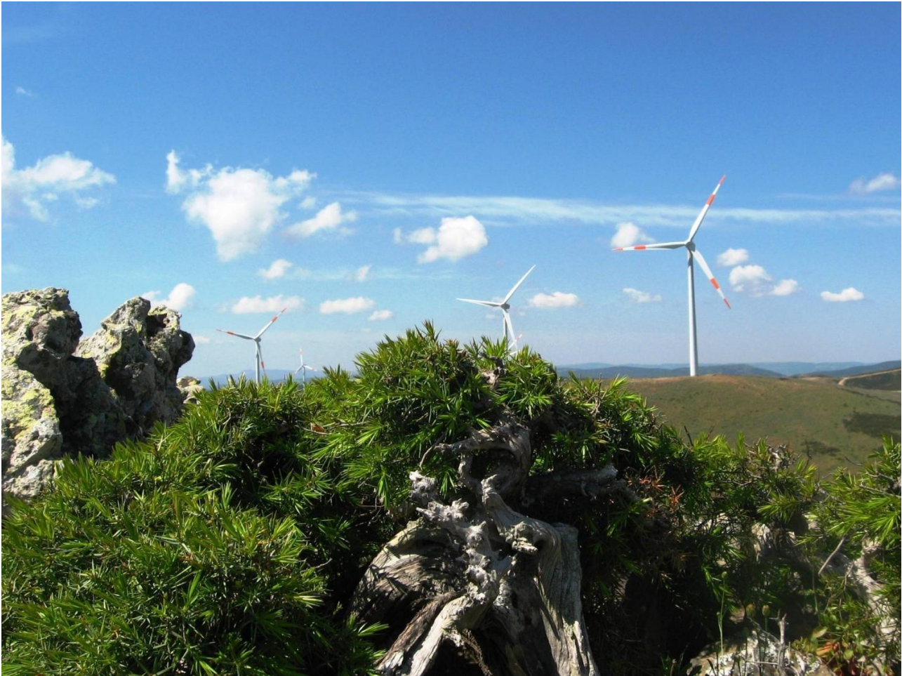
Figura 10: Scorcio del Parco Eolico
